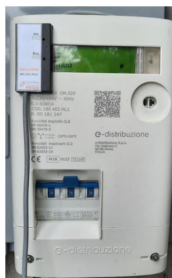
Smart meter con sensore WZ-CNT-PLUS
