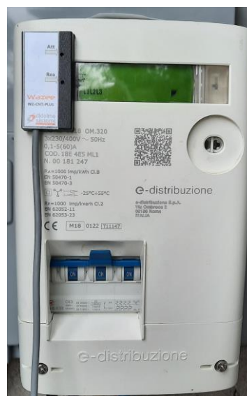
Smart meter con sensore WZ-CNT-PLUS
